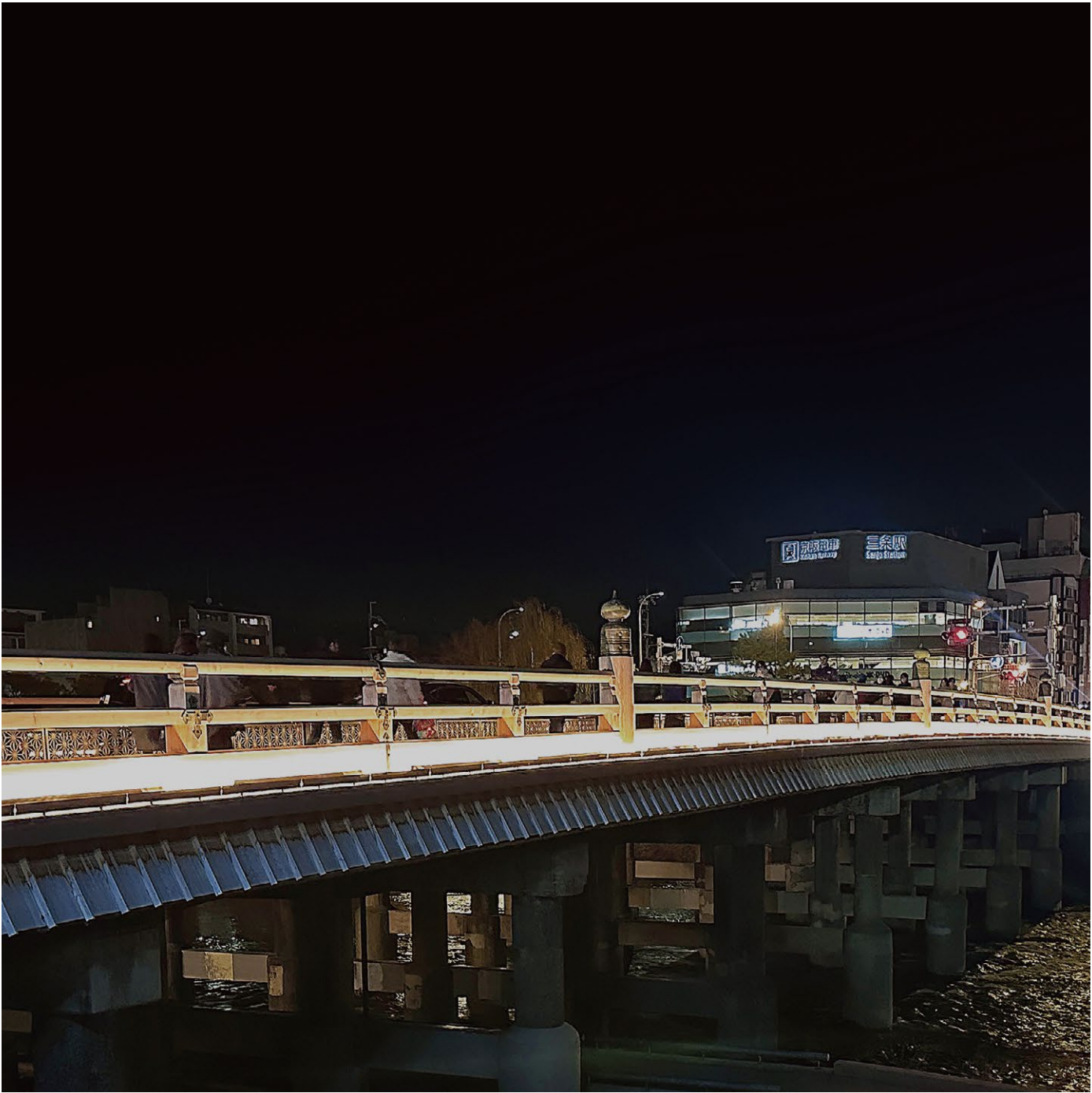
三条大橋補修工事(その1)
